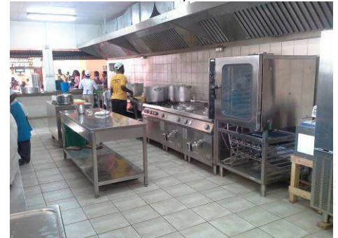
La cucina della mensa, dopo l'intervento:
